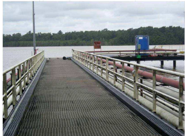
Passerelle d'accès (Source EGIS EAU)
